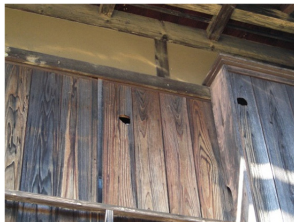
図8 雨戸に開けられた穴 2)
