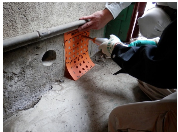
図 28 テストハンマーによる調査 3)
