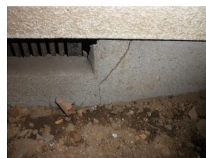
図 15 基礎のひび割れ 3)
