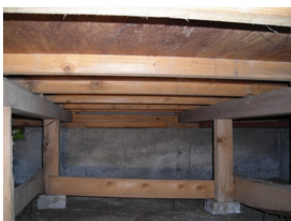
図 11 1 階床下の調査 3)
