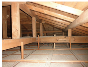
図1 小屋裏の調査
