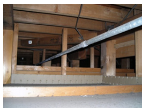
図3 2階床下の調査
