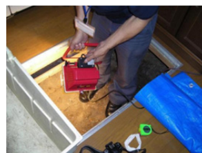
図4 床下収納からの調査
