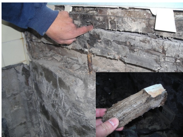
図6 木材の腐朽
